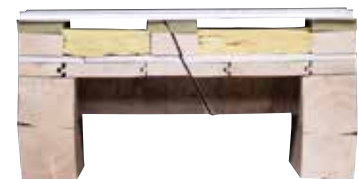
Sichtbare Balkenkonstruktion
